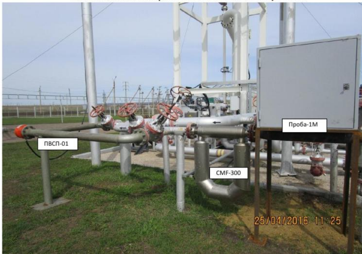
Фото 2. Монтаж автоматического пробоотборника «Проба-1М» в технологическую линию
