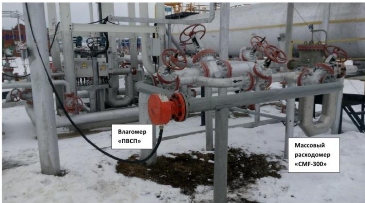
Фото 1. Монтаж влагомера «ПВСП-01» в технологическую линию
