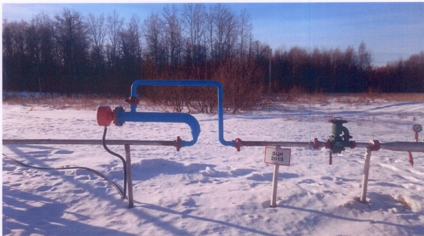
Рис. 1. Установленный влагомер «ПВСП-01» на скважине №2015
